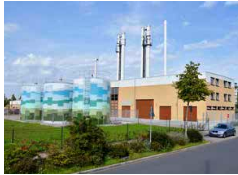
Das Heizkraftwerk in der Fronmüllerstraße kann am 23. Juni ebenfalls besichtigt werden
